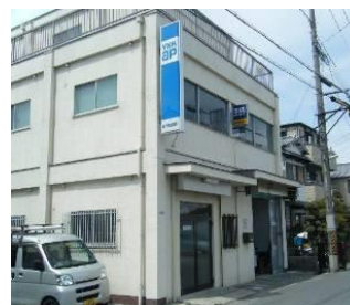
社屋 (事務所・工場)
