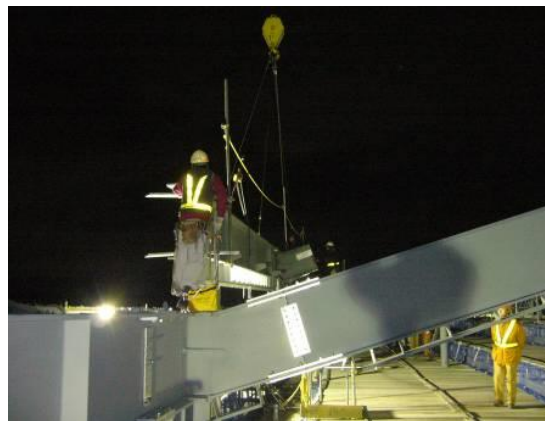
【淀駅鉄骨屋根工事（夜間）】
