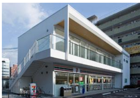
ヤマシタ門真（ガラス手摺施工）
